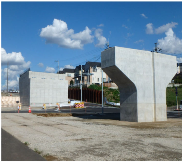
社会資本整備総合交付金工事（仮称） 三郷流山橋取付高架橋P10橋脚・A2橋台
