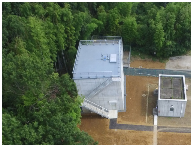
椎の森配水槽築造工事
