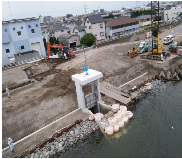
県単河川改修工事（堀江樋管工）
