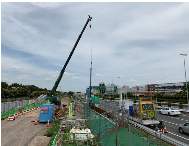
H30・H31国道357号市川共同溝補強その11工事
