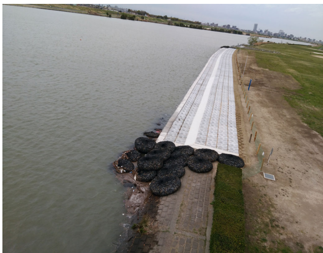
R1江戸川左岸大洲地区低水護岸災害復旧工事 発注者：国土交通省関東地方整備局 江戸川河川事務所 令和3年3月完成
