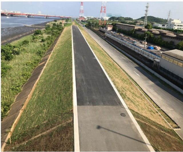
R1江戸川右岸妙典6丁目下流地区高潮堤防整備工
