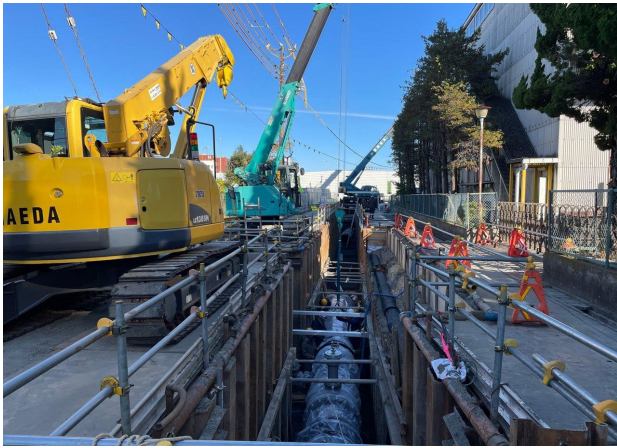
配水管更新工事（鬼高B工区）
