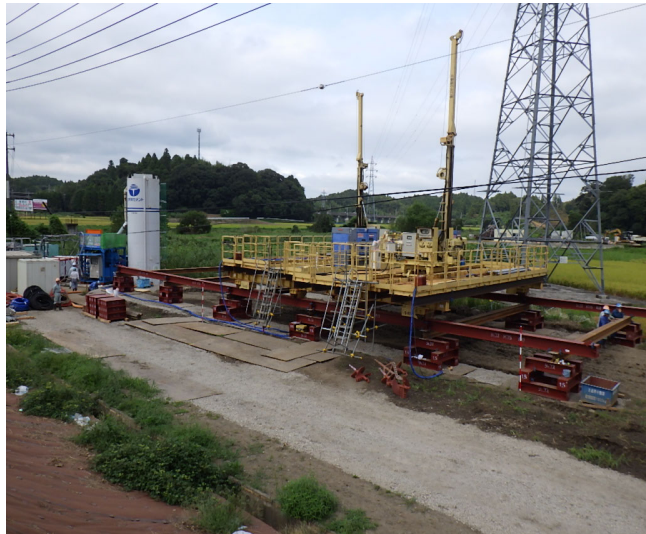
H30・H31国道51号山之作地区他改良その2工事
