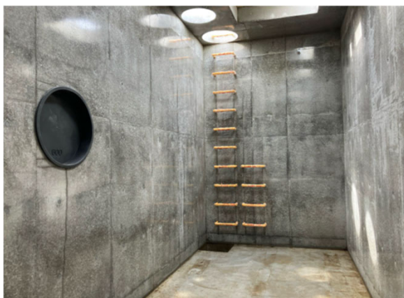
中央浄化センター返汚泥ポンプ槽建設工事
