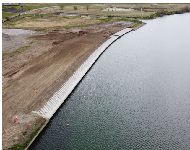
R1江戸川左岸鷹野1丁目地先低水護岸災害復旧工事 発注者：国土交通省関東地方整備局 江戸川河川事務所 令和3年3月完成
