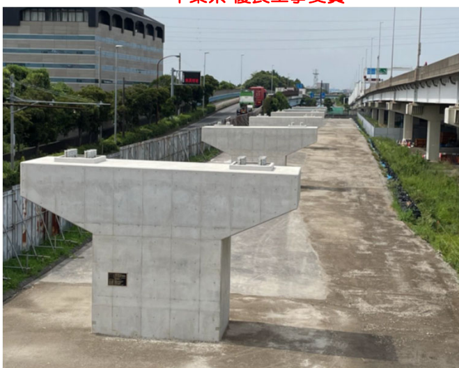
R1国道357号塩浜立体海側下部その8工事 発注者：国土交通省関東地方整備局 首都国道事務所 令和3年8月完成
