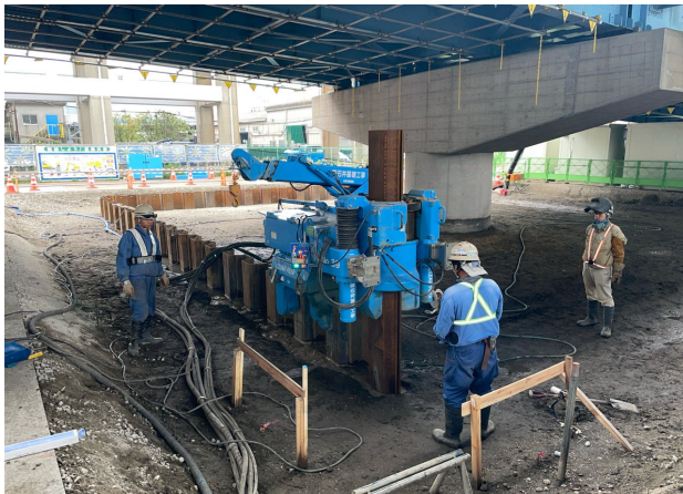
R5国道357号海老川大橋下部その2工事
